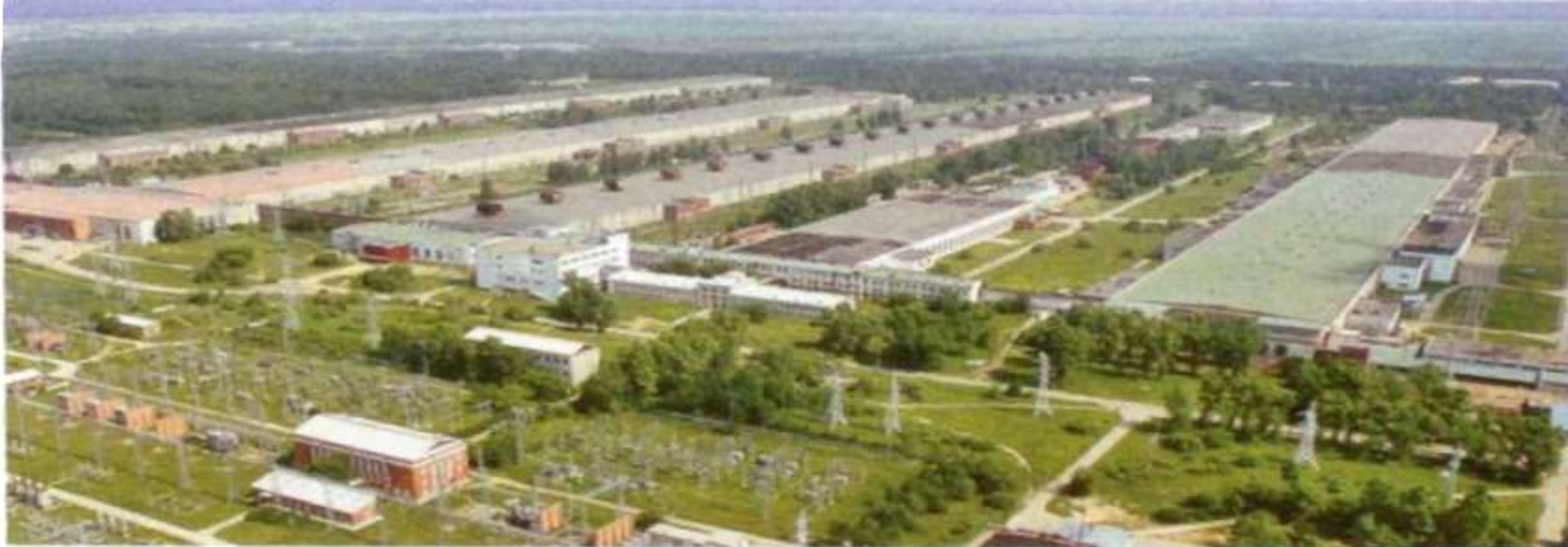
Промплощадка комбината по обогащению урана (Ангарский электролизный химический комбинат)
