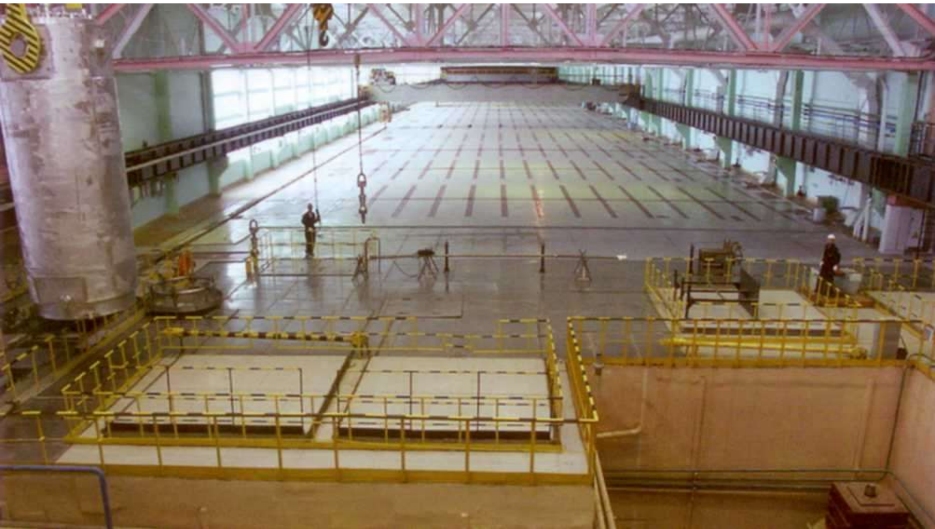
Зал мокрого хранилища ОЯТ на ГХК
